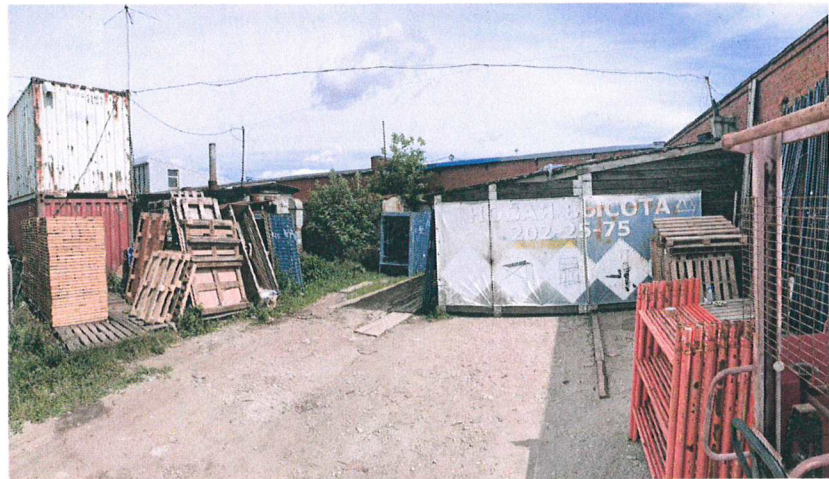
Дворовой фасад в осях 1-2
